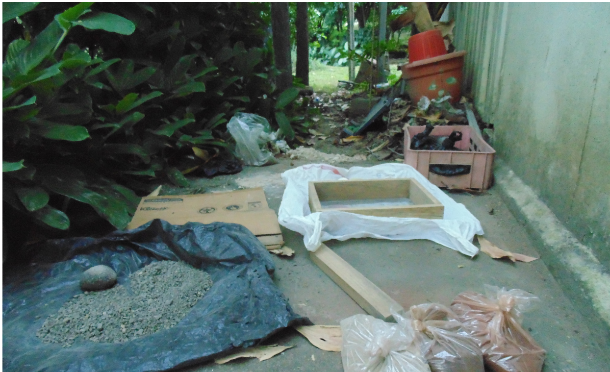
Figura 5. Fotografía del proceso de pulverizado y tamizado.
